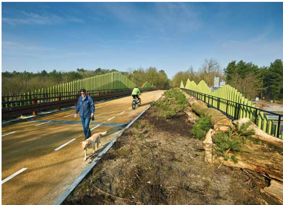
Het aantal biobased projecten is heel beperkt. Het blijft bij een paar opdrachtgevers die willen experimenteren. Zoals het viaduct in Bergen op Zoom waar de provincie Noord-Brabant lignine als bindmiddel heeft laten toepassen.
