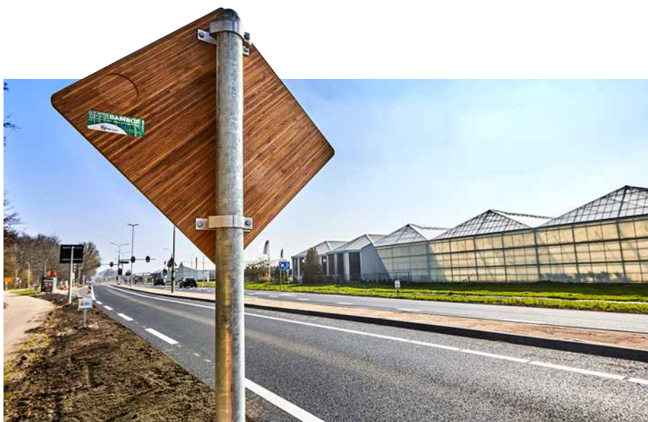
De provincie Noord-Holland heeft 1 kilometer van de N321 biobased ingericht, onder andere met biobased verkeersborden. Dat is veel meer dan een proeftuin, verzekert Robbert Naus.
