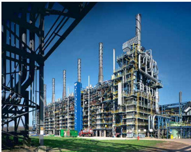
Naftakraker die de pyrolyse olie gaat verwerken. Deze nieuwe fabriek voor pyrolyse olie wordt naast de naftakraker gebouwd.
