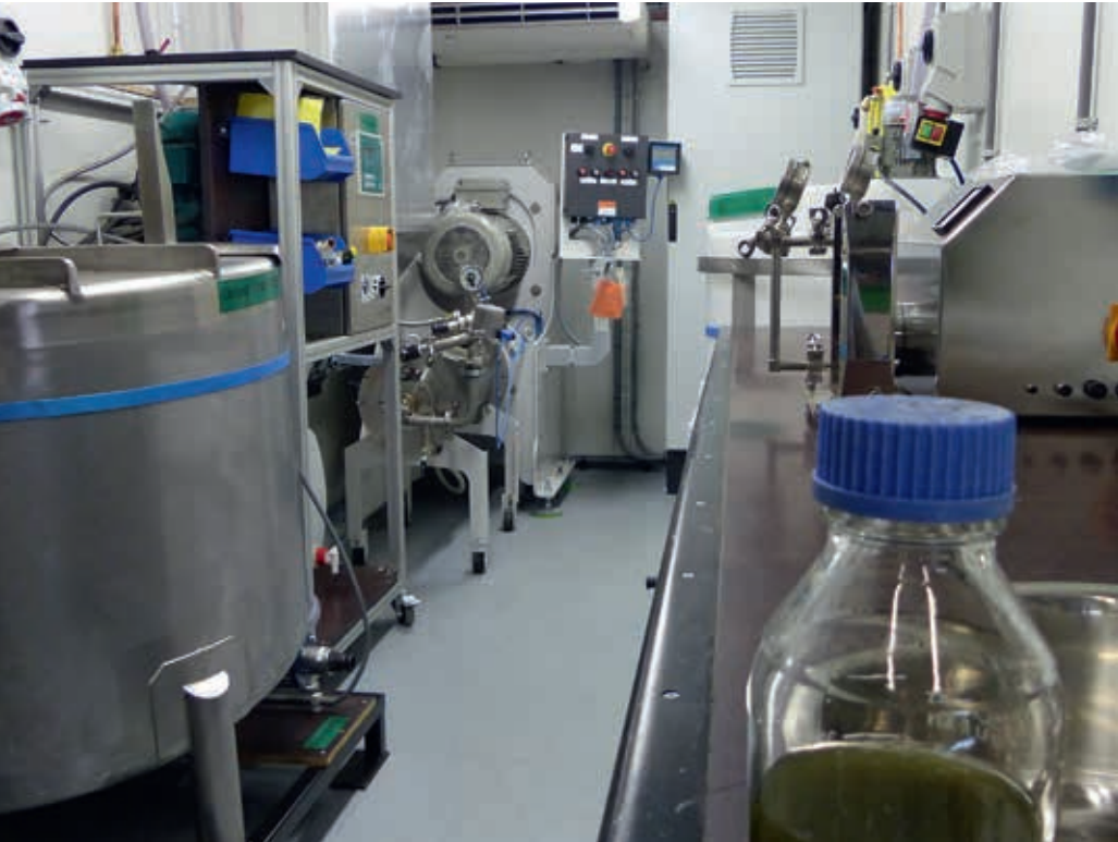
Valorie, de mobiele container met daarin diverse procesapparatuur om raffinage te kunnen uitvoeren. Linksachter in de hoek staat de beadmill, voor mechanische celdisruptie. Daarnaast bevat Valorie een opslag-tank voor algen, een centrifuge, extractieapparatuur e.d.
