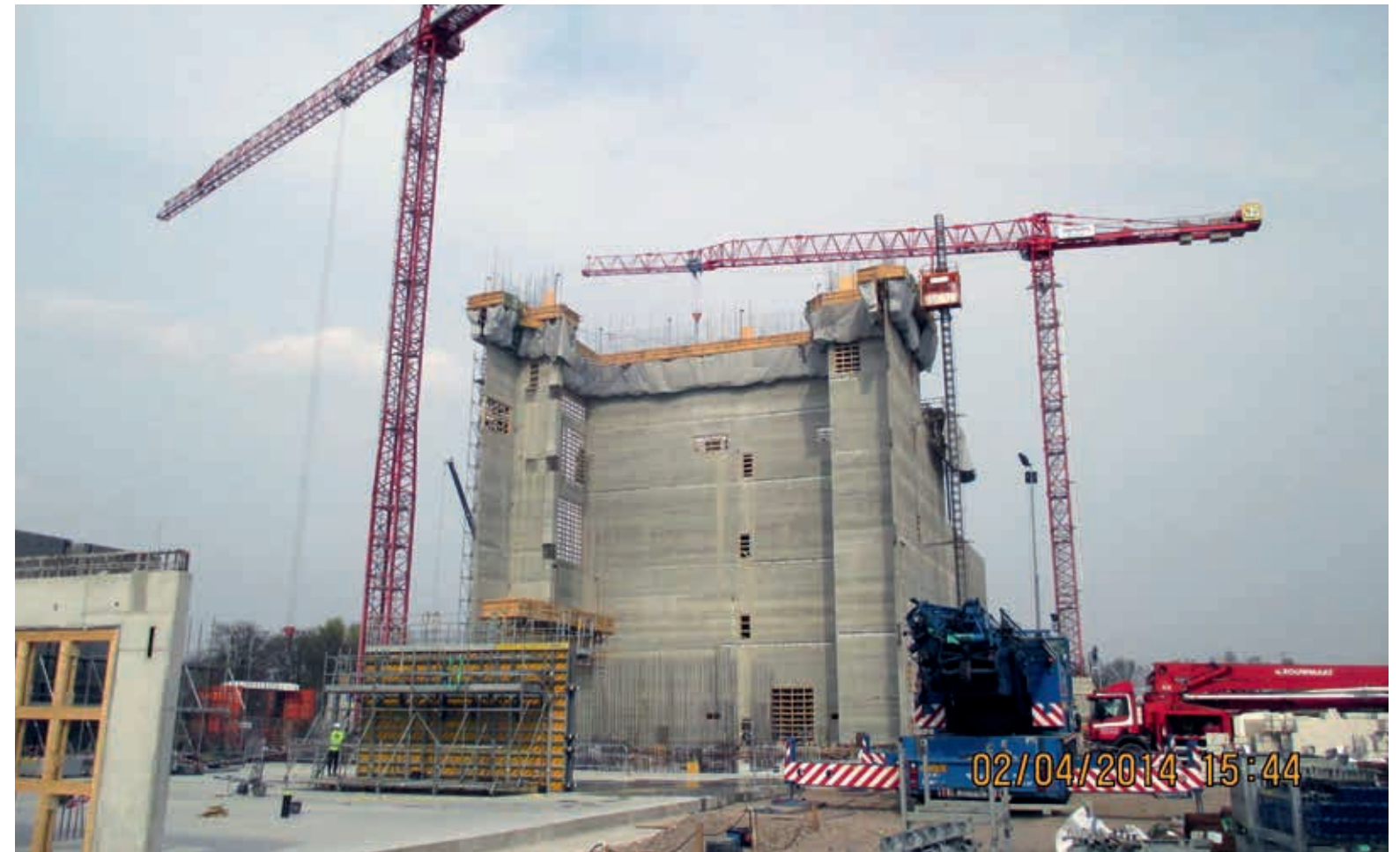
De nieuwe fabriek in aanbouw.
