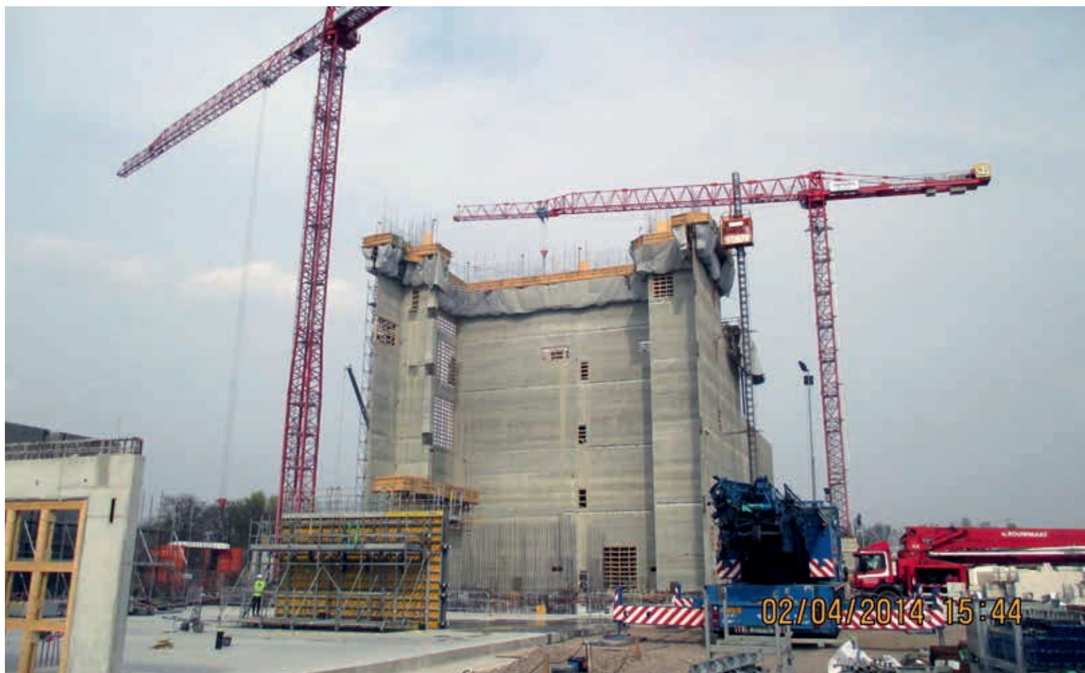
De nieuwe fabriek in aanbouw.
