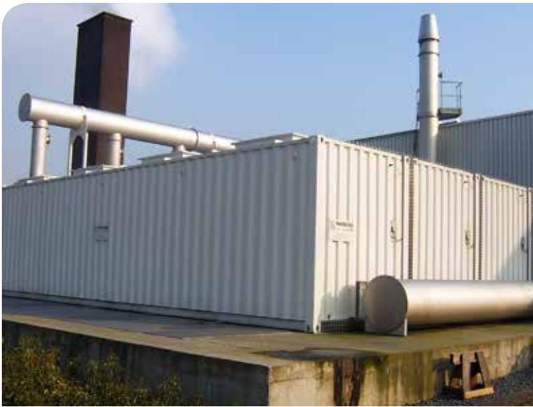
— Boomschors met geactiveerd compost oxideert de giftige stoffen tot water en kooldioxide.
