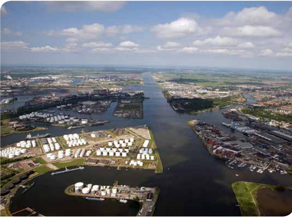
— Grootse plannen. Wellicht kan Haven Amsterdam in de nabije toekomst uitgroeien tot een biogashub, een 'energiefabriek' met hoog rendement groengas dat het hele havengebied en omgeving kan bedienen.
