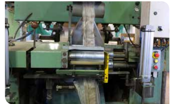
— De fabriek heeft twee volledig mechanische verwerkingslijnen.
